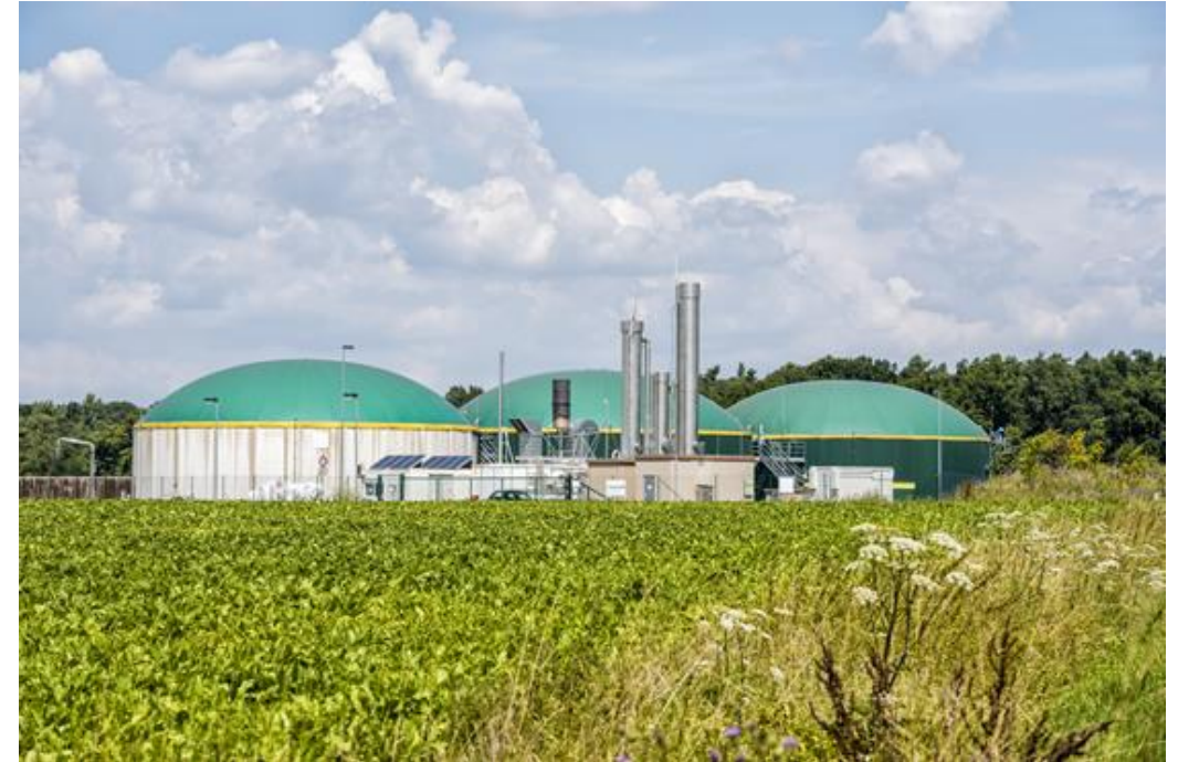
Un site de production de biométhane
